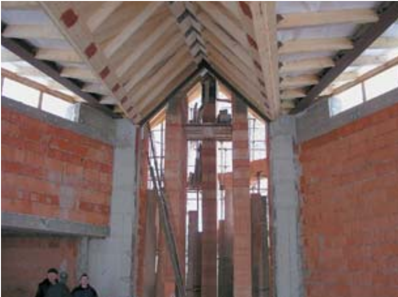
Interiér kostela v průběhu hrubé stavby
