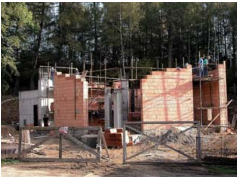
Stavba nosných zdí a betonáž základů kostela
