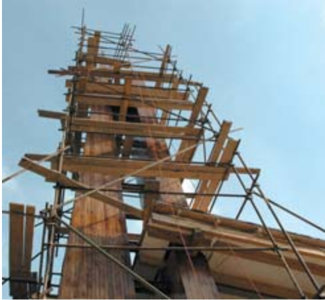
Bednění a montáž konstrukce věže
