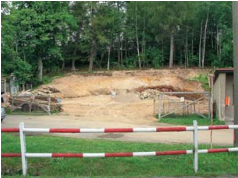
Úprava terénu před stavbou kostela
