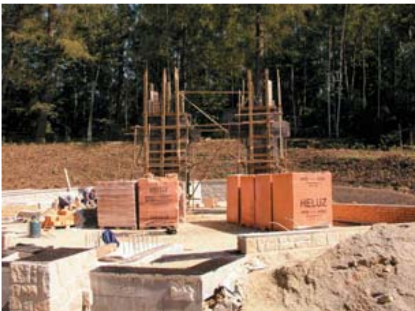
Kamenný sokl kostela a zahájení zdění zdiva
