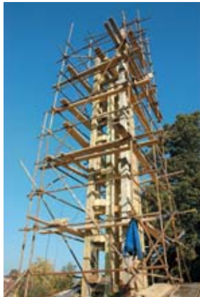
Bednění a montáž konstrukce věže
