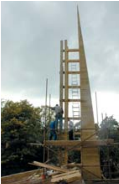
Bednění a montáž konstrukce věže
