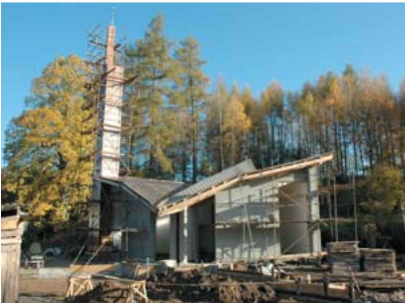
Před dokončením hrubé stavby
