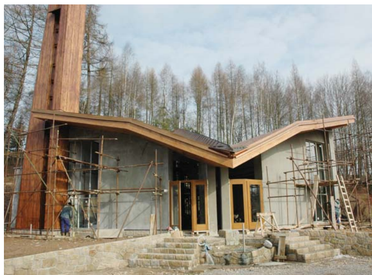
Práce na kostele postupovaly bez větších obtíží. Na snímku je stavba zachycena už nedlouho před svým dokončením.
