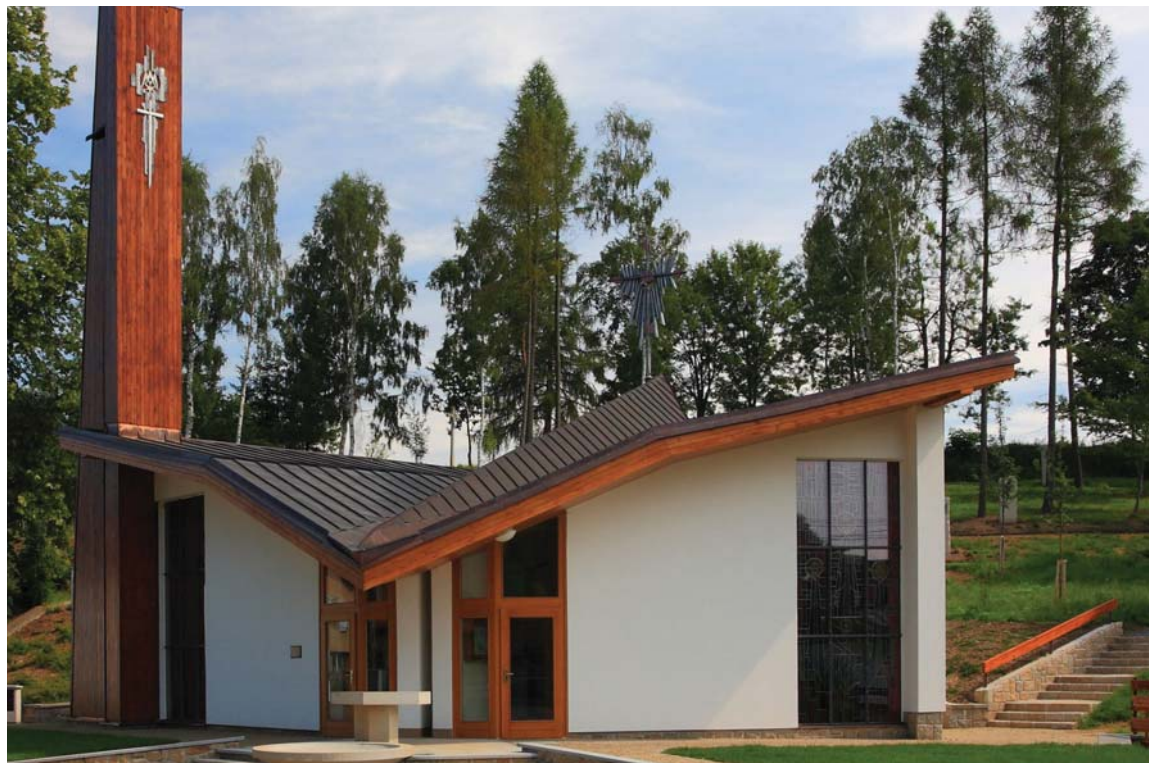
Dílo architekta Ludvíka Kolka bylo dokončeno v roce 2008.
